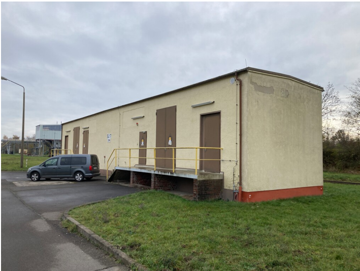
Trafostation, Blick nach Südost Fotograf/Urheber: Nils Schinker
