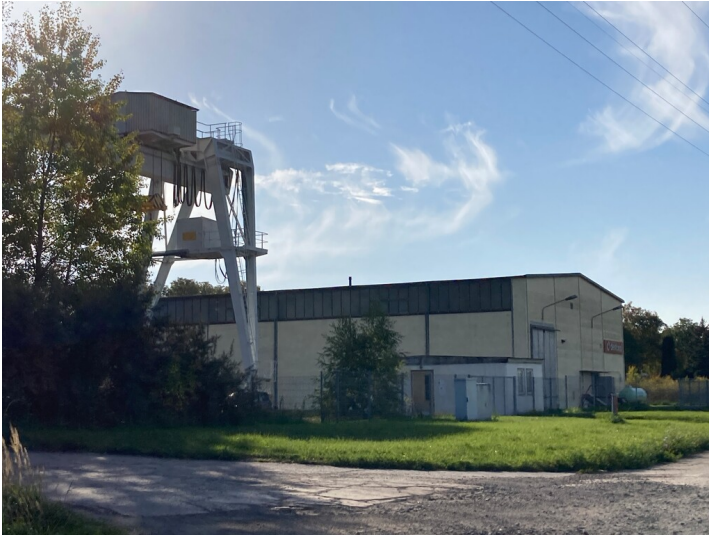
Altkraftwerk Lippendorf, Lagerhalle mit Krananlage; Blick nach Südwest Fotograf/Urheber: Nils Schinker
