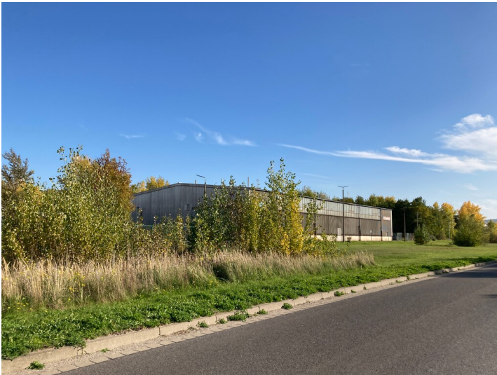
Altkraftwerk Lippendorf, Werk- und Lagerhalle, Blick nach Südost Fotograf/Urheber: Nils Schinker
