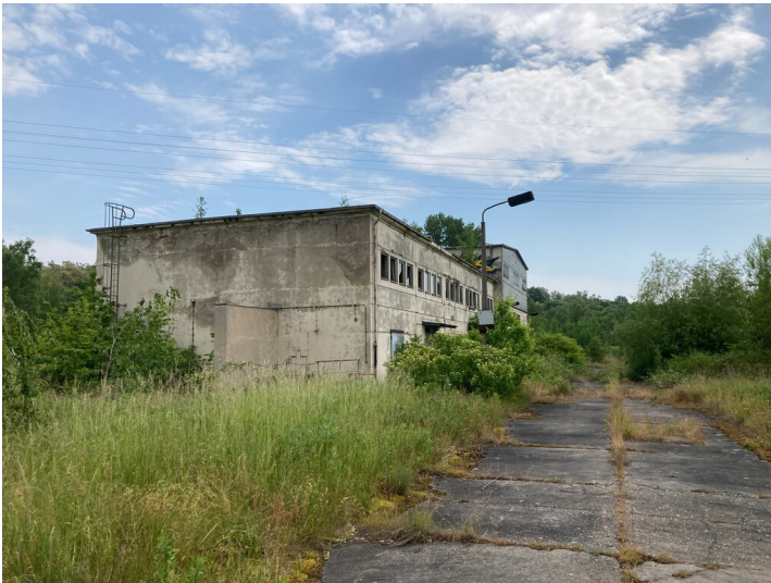
Altkraftwerk Lippendorf, Sozialgebäude mit Laborhalle; Blick nach Südost Fotograf/Urheber: Nils Schinker
