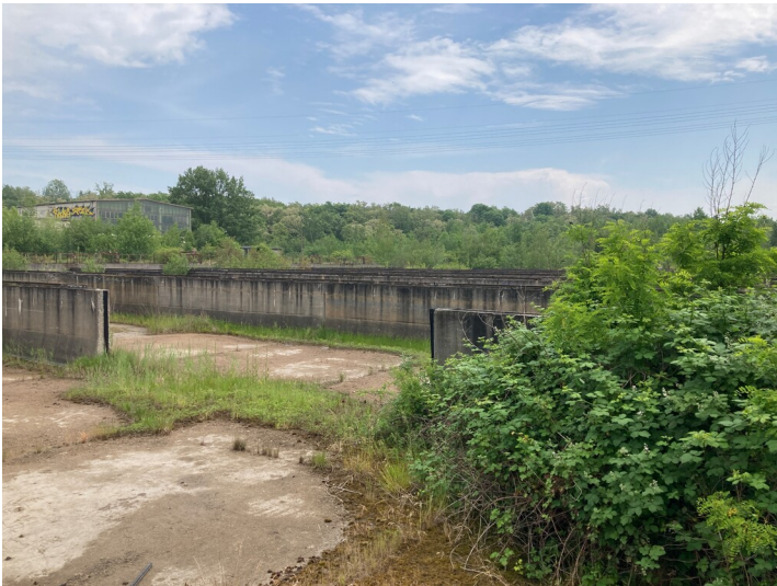
Altkraftwerk Lippendorf, Kläranlage, Blick in die Reinigungsbecken nach Südost in Richtung Halde Lippendorf Fotograf/Urheber: Nils Schinker
