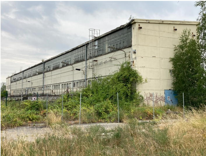
Altkraftwerk Lippendorf, Pumpenhaus, Blick nach Südwest in Richtung der Beckenanlage Fotograf/Urheber: Josephine Dressler
