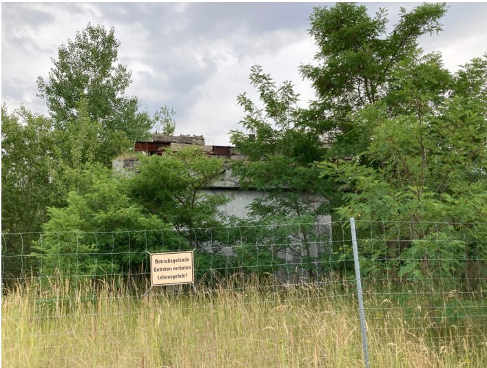
Alt-Kraftwerk Lippendorf, Grabenbunker, Blick nach Südost in Richtung Halde Lippendorf Fotograf/Urheber: Nils Schinker
