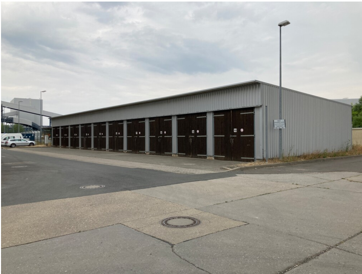
Altkraftwerk Lippendorf, Garagenbau mit zehn Einzelgaragen, Blick nach Nordost Fotograf/Urheber: Josephine Dressler
