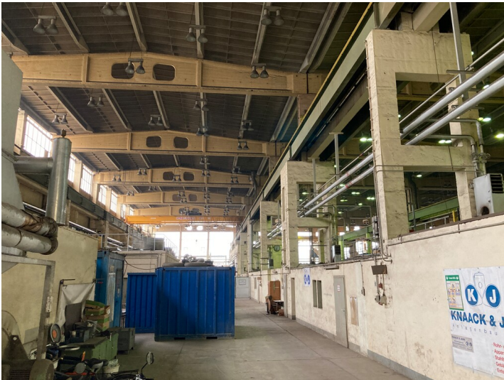
Altkraftwerk Lippendorf, Werkstattgebäude, Innenraum mit Laufkatze Fotograf/Urheber: Josephine Dressler
