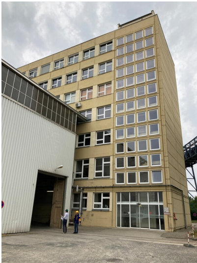
Altkraftwerk Lippendorf, Verwaltungsgebäude, Eingang mit Treppenhaus, Blick nach Westen Fotograf/Urheber: Josephine Dressler
