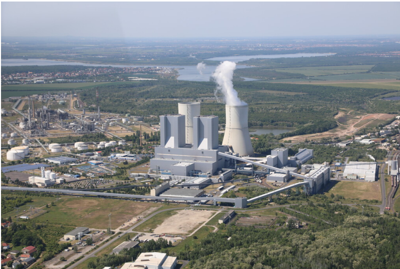
Altkraftwerk Lippendorf, Schrägluftbild von Süden mit den Altbauten im Vordergrund des Kraftwerks Lippendorf Fotograf/Urheber: Ronald Heynowski
