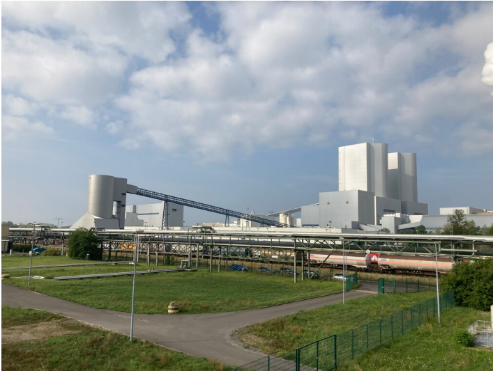
Großer Hallenkomplex mit Büro- und Sozialräumen, Blick nach Westen mit Kraftwerk Lippendorf im Hintergrund Fotograf/Urheber: Nils Schinker
