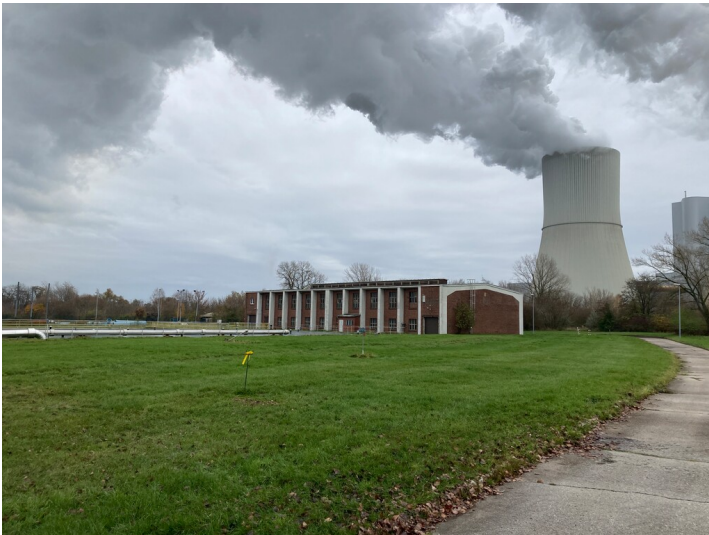
Wasserwerk, Blick nach Osten Richtung Kraftwerk Lippendorf Fotograf/Urheber: Nils Schinker
