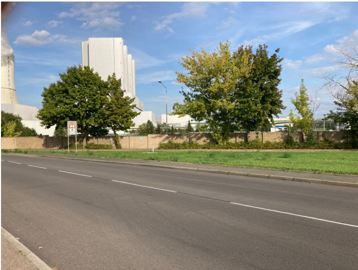
Einfriedungsmauer des früheren Gaswerks Böhlen, Blick nach Osten Fotograf/Urheber: Ullrich Ochs
