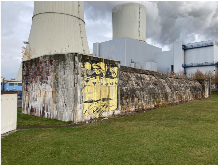
Luftschutzbunker aus Stahlbeton, Blick nach Nordost in Richtung Kraftwerk Lippendorf Fotograf/Urheber: Nils Schinker
