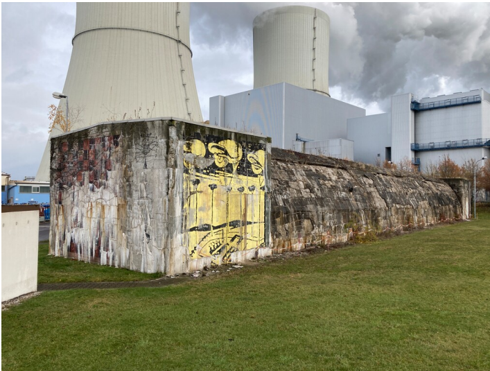
Luftschutzbunker aus Stahlbeton, Blick nach Nordost in Richtung Kraftwerk Lippendorf Fotograf/Urheber: Nils Schinker
