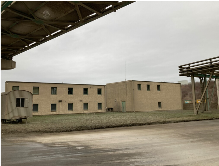
Tagebau Vereinigtes Schleenhain, Leitstand, rechtes Gebäude im Bild, Blick nach Nordwest Fotograf/Urheber: Nils Schinker
