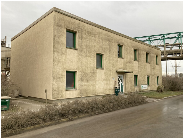
Tagebau Vereinigtes Schleenhain, Büro- und Sozialgebäude, Blick nach Nordost Fotograf/Urheber: Nils Schinker
