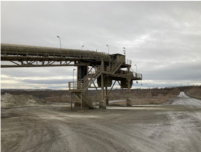
Tagebau Vereinigtes Schleenhain, Verladeanlage für das Trockenaschegemisch zur Tagebausanierung, Blick nach Südwest Fotograf/Urheber: Nils Schinker
