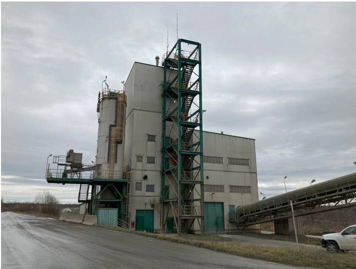
Tagebau Vereinigtes Schleenhain, Verwertungsanlage 2 mit Wasserzufuhr, Blick nach Osten Fotograf/Urheber: Nils Schinker
