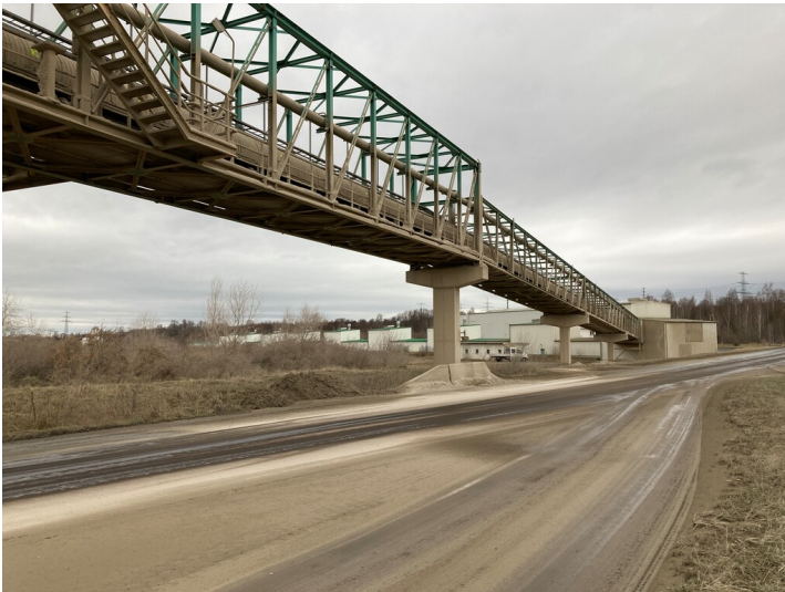
Tagebau Vereinigtes Schleenhain, Bandförderanlage Aschetransport, Blick nach Nordwest Fotograf/Urheber: Nils Schinker
