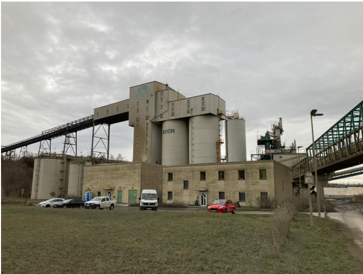
Tagebau Vereinigtes Schleenhain, Verwertungsanlage 1 mit Wasserzufuhr, Blick nach Südost Fotograf/Urheber: Nils Schinker
