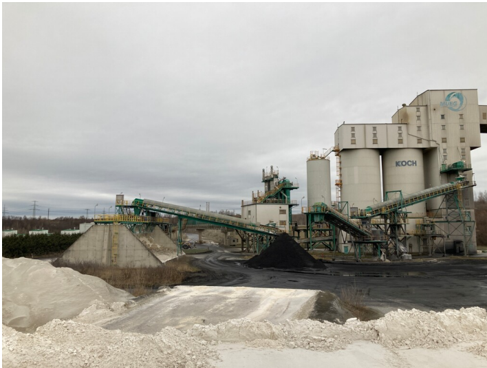
Tagebau Vereinigtes Schleenhain, Lagerplatz für Gips und Nassasche, Blick nach Norden Fotograf/Urheber: Nils Schinker
