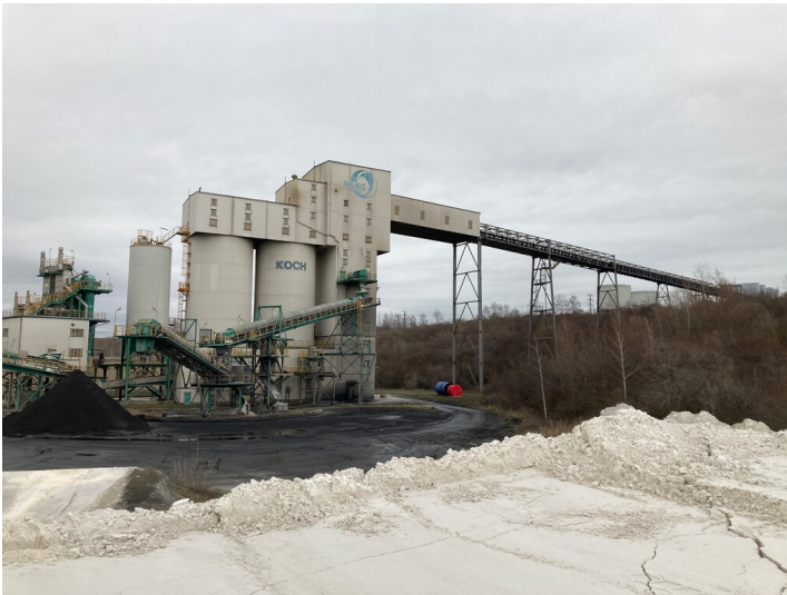
Tagebau Vereinigtes Schleenhain, Silo- und Verladegebäude, Blick nach Nordwest Fotograf/Urheber: Nils Schinker
