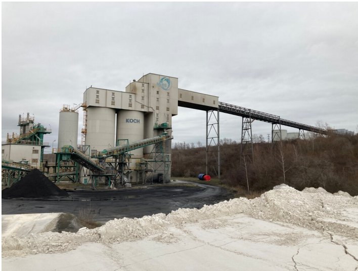
Tagebau Vereinigtes Schleenhain, Silo- und Verladegebäude, Blick nach Nordwest Fotograf/Urheber: Nils Schinker
