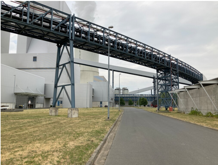
Tagebau Vereinigtes Schleenhain, Rohrgurtförderbrücke zum Abtransport von Aschen, Gips und Restwasser, Blick nach Norden Fotograf/Urheber: Josephine Dressler
