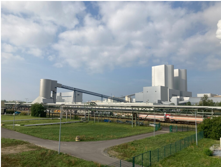
Kraftwerk Lippendorf, Gipstransportbrücke zur Güterbahn, Blick nach Südwest Fotograf/Urheber: Nils Schinker
