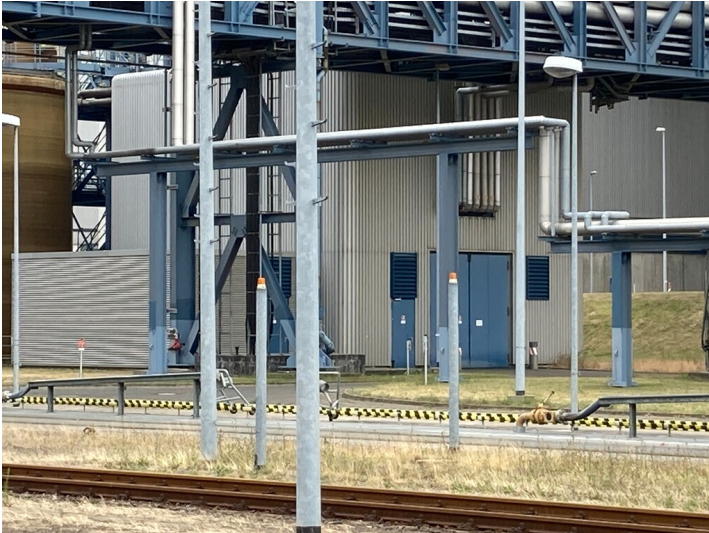
Kraftwerk Lippendorf, Pumpenhaus Ausschleuswasser, Blick nach Südost Fotograf/Urheber: Josephine Dressler
