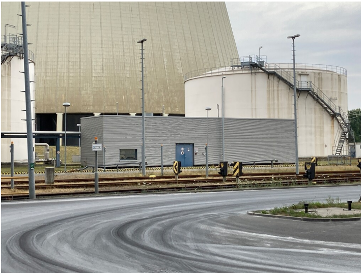
Kraftwerk Lippendorf, Heizölpumpenhaus der Heizölladestation, Blick nach Osten Fotograf/Urheber: Josephine Dressler
