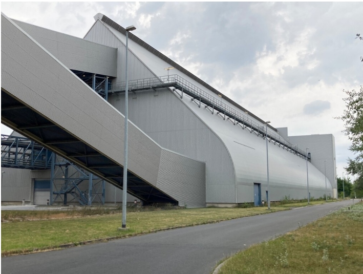
Kraftwerk Lippendorf, Transportbrücke, Blick nach Norden Fotograf/Urheber: Josephine Dressler
