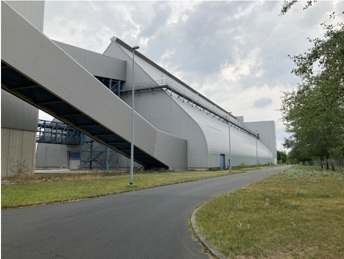
Kraftwerk Lippendorf, Transportbrücke mit Gefälle, Blick nach Norden zur Gipshalle Fotograf/Urheber: Josephine Dressler
