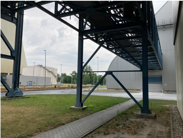
Kraftwerk Lippendorf, Rohrbrücke, Blick nach Norden zur Gipshalle Fotograf/Urheber: Nils Schinker
