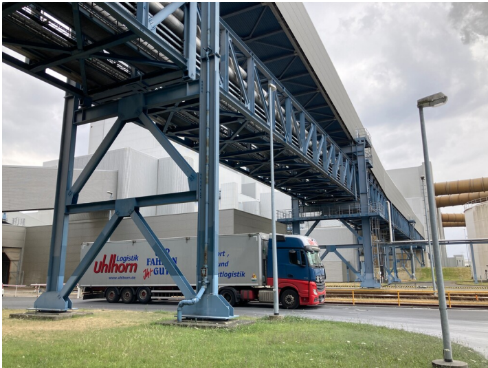
Kraftwerk Lippendorf, Transportbrücke für Kalksuspension, Blick nach Westen Fotograf/Urheber: Josephine Dressler
