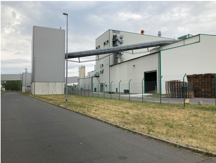
Kraftwerk Lippendorf, Verteilergebäude (Süd) mit Bandförderbrücken, Blick nach Norden Fotograf/Urheber: Josephine Dressler
