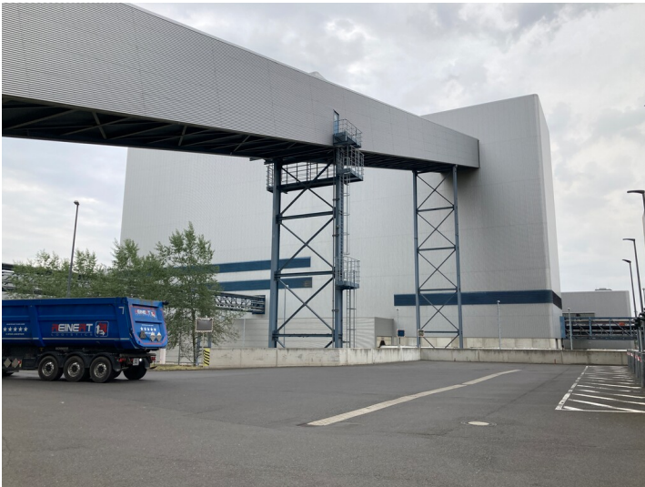
Kraftwerk Lippendorf, Nassaschebandförderbrücke, Blick nach Nordost Fotograf/Urheber: Josephine Dressler
