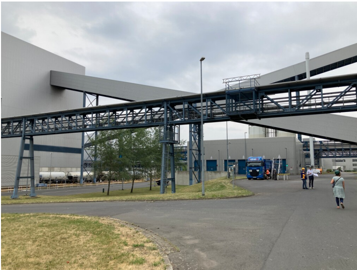
Kraftwerk Lippendorf, Trockenaschebandbrücke, Blick von Norden Fotograf/Urheber: Josephine Dressler
