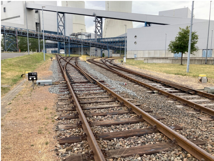
Kraftwerk Lippendorf, Gleisanlagen auf dem Kraftwerksgelände, Blick von Südost Fotograf/Urheber: Josephine Dressler
