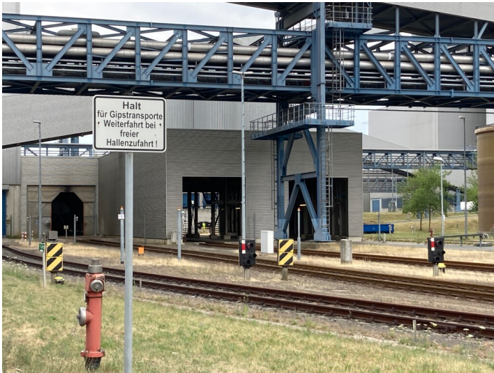
Kraftwerk Lippendorf, Verladestation für Kalk und Gips, Blick von Norden Fotograf/Urheber: Josephine Dressler
