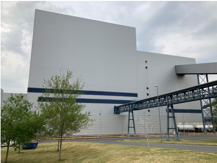
Kraftwerk Lippendorf, Gebäudekomplex der Siloanlagen für Trocken- und Nassasche, Blick von Osten Fotograf/Urheber: Josephine Dressler
