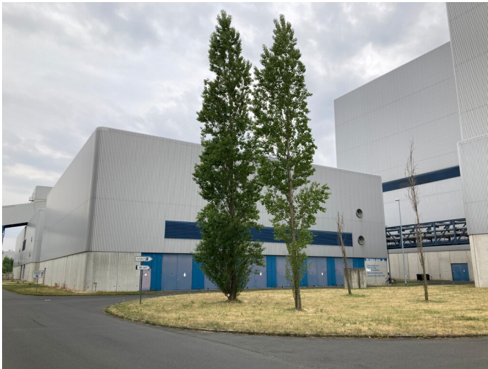
Kraftwerk Lippendorf, Schaltanlagegebäude der Nebenanlagen, Blick von Nordost Fotograf/Urheber: Josephine Dressler
