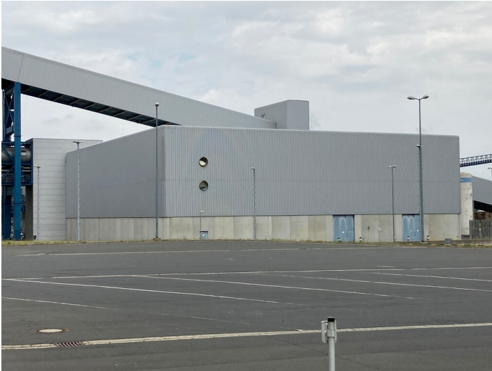
Kraftwerk Lippendorf, Gebäudekomplex der Wasseraufbereitung, Blick von Südwest Fotograf/Urheber: Josephine Dressler
