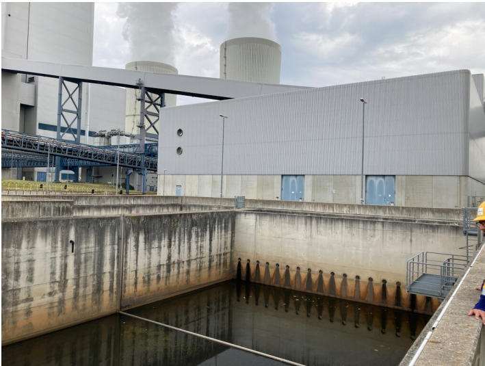
Kraftwerk Lippendorf, Rückhaltebecken für Feuerlösch- und Regenwasser, Blick von Südost Fotograf/Urheber: Nils Schinker
