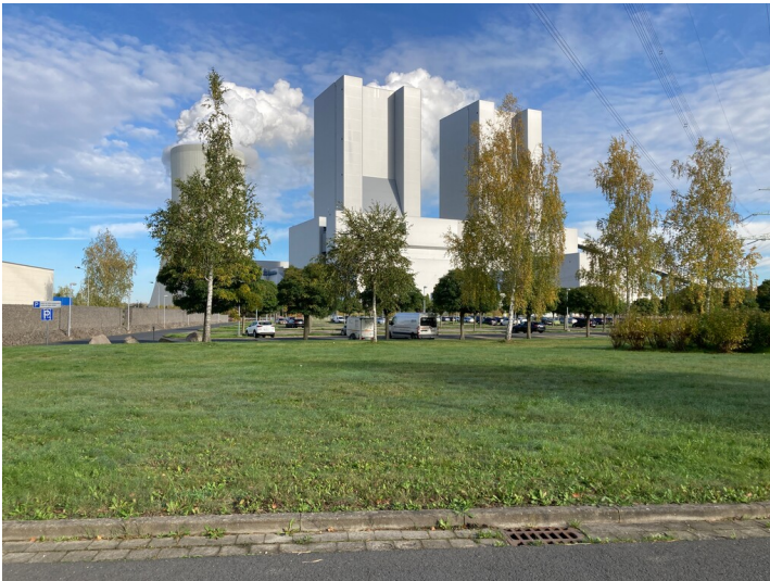
Kraftwerk Lippendorf, Parkplatz für Besucher und Mitarbeiter sowie Bushaltestelle, Blick von Süden Fotograf/Urheber: Nils Schinker
