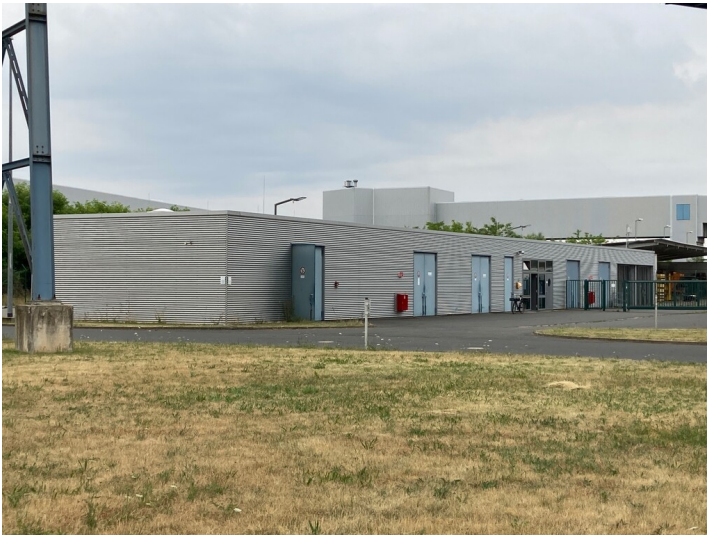
Kraftwerk Lippendorf, Lagergebäude, Blick nach Südost Fotograf/Urheber: Josephine Dressler
