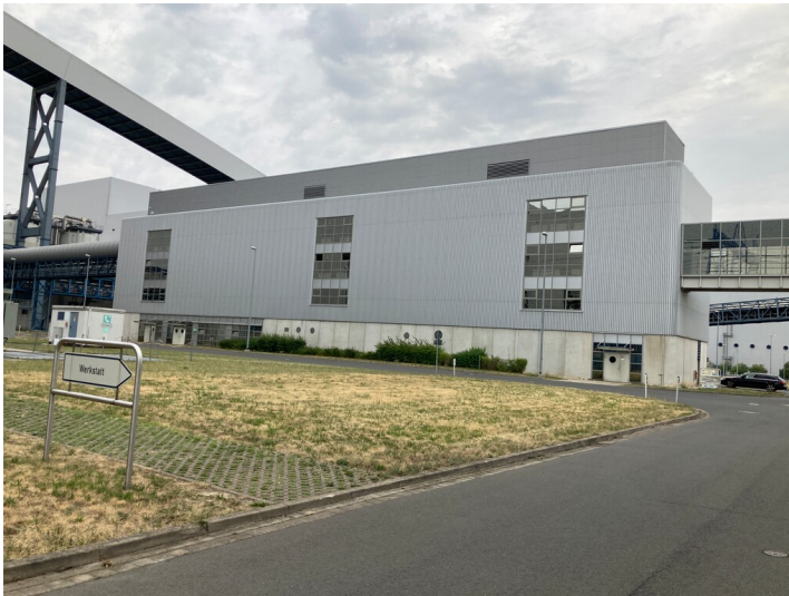
Kraftwerk Lippendorf, Sozialgebäude mit Waschkaue, Blick von Südwest Fotograf/Urheber: Josephine Dressler
