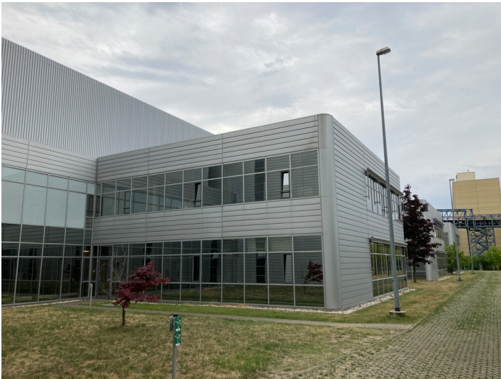
Kraftwerk Lippendorf, Werkstattgebäude, Blick von Nordwest Fotograf/Urheber: Nils Schinker
