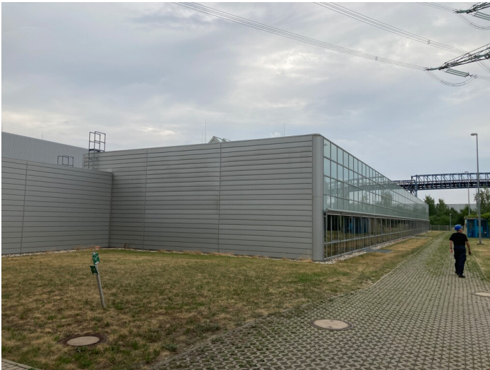
Kraftwerk Lippendorf, Lehrgebäude, Blick von Norden Fotograf/Urheber: Nils Schinker
