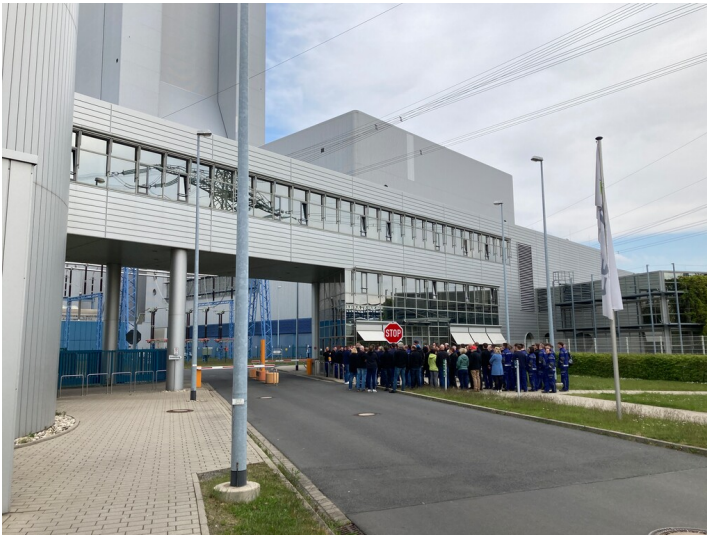
Kraftwerk Lippendorf, Eingang mit Kantinegebäude, Blick von Südwest Fotograf/Urheber: Nils Schinker
