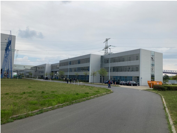
Kraftwerk Lippendorf, Verwaltungsgebäude, westlicher Teil des Eingangsgebäudes, Blick von Nordwest Fotograf/Urheber: Nils Schinker
