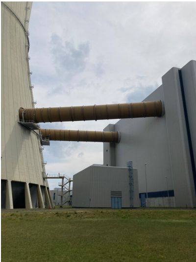
Kraftwerk Lippendorf, Nebengebäude der Pumpenhäuser, Blick von Westen Fotograf/Urheber: Nils Schinker
