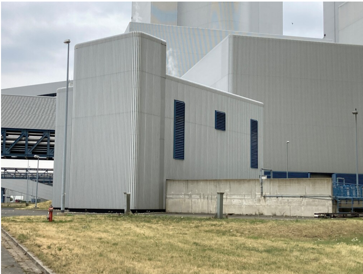
Kraftwerk Lippendorf, Kühlwasserpumpenhaus S, Blick von Nordost Fotograf/Urheber: Josephine Dressler
