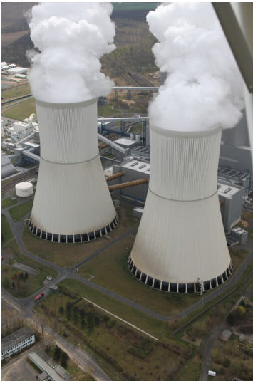
Kraftwerk Lippendorf, Naturzug-Nasskühlturm R und S, Schrägluftaufnahme von Nordwest Fotograf/Urheber: Ronald Heynowski
